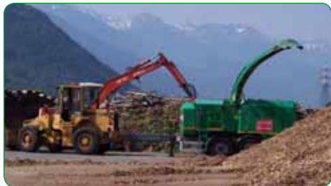
Impianto biomassa, Tirano
