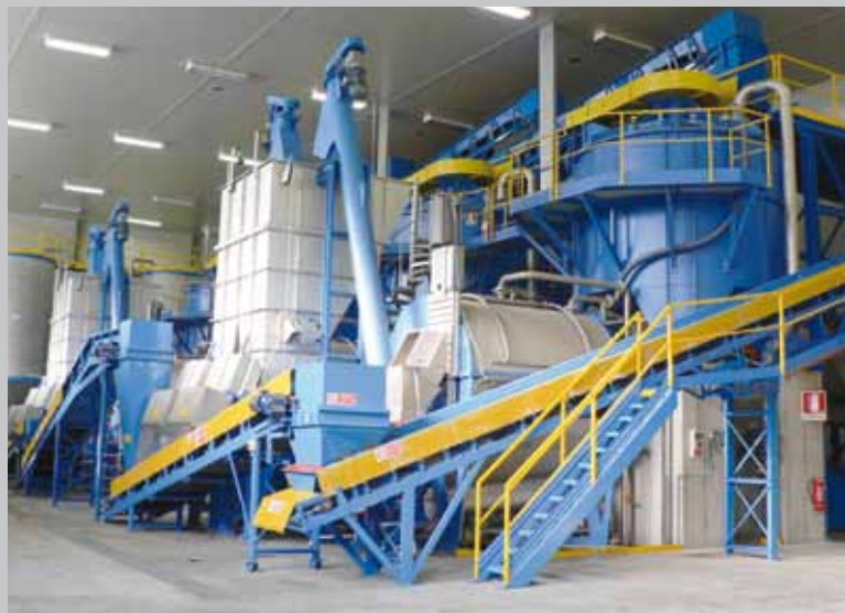
Digestore affiancato dall'edificio per il post trattamento di centrifugazione del digestato
